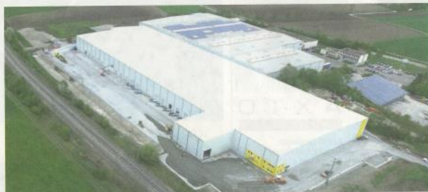
Am Vellberger Standort wurde eine 16000 Quadratmeter große Logistikhalle mit höchsten Sicherheitsstandards gebaut. Foto: Schmitt-Gruppe
