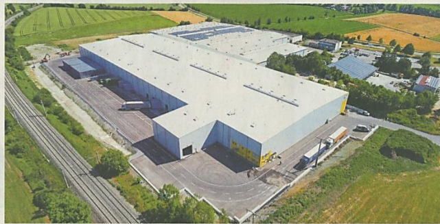
Am Vellberger Standort wurde eine 16.000 Quadratmeter große Logistikhalle erbaut. Die 210 Meter lange, 75 Meter breite und zehn Meter hohe Halle verfügt über neueste Technik und erfüllt höchste Sicherheitsstandards.
