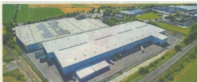
Seit 1983 liegt der Stammsitz der Unternehmensgruppe in Vellberg-Talheim. Hier befindet sich auf einer Fläche von 16.000 Quadratmetern auch der 2019 fertiggestellte Logistikneubau. Foto: Schmitt Gruppe
