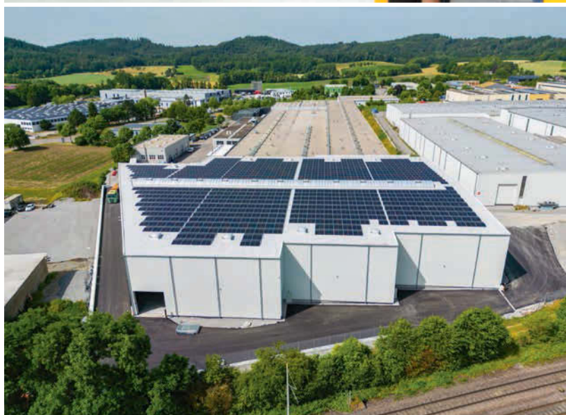
Photovoltaik auf dem Dach, Verschieberegalanlage im Inneren: Letztere bewegt das Gefahrgut im Sulzdorf Lagerstandort 8.
