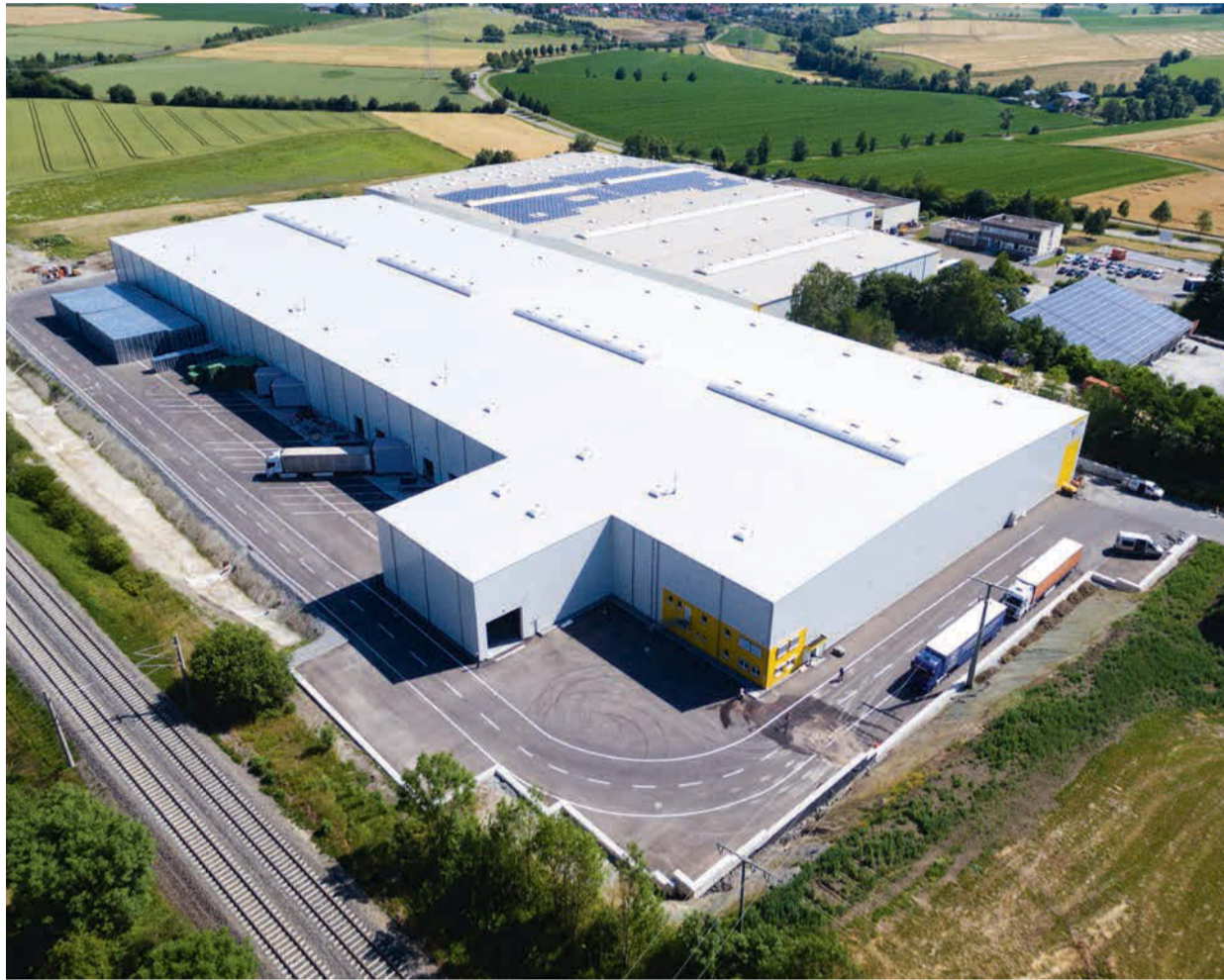
Vellberg Lagerstandort 5: Das erste Gefahrstofflager wurde in 15 Monaten geplant, genehmigt und schließlich gebaut.
